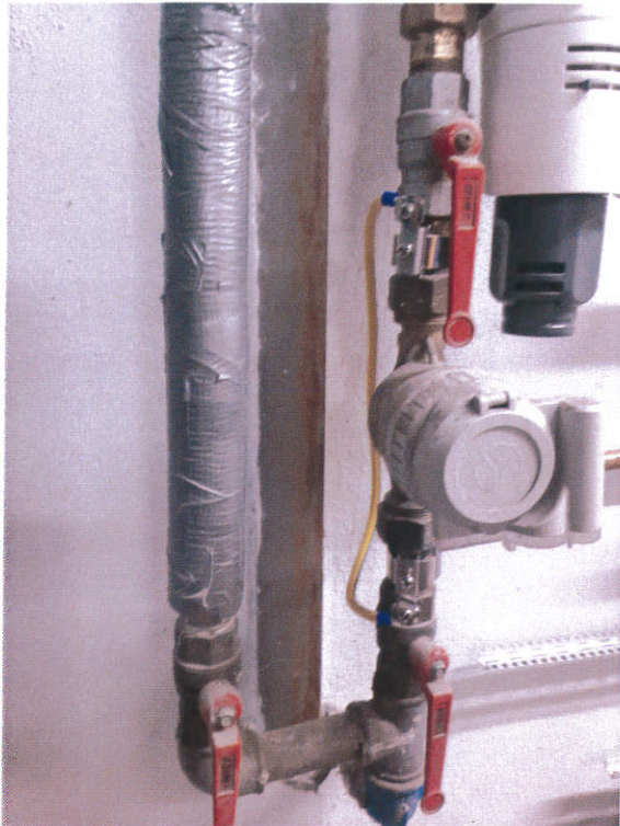
Bild 7: Potentialausgleich Wasserzähler
