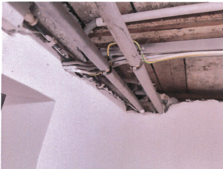
Bild 8: Potentialausgleich Heizleitungen
