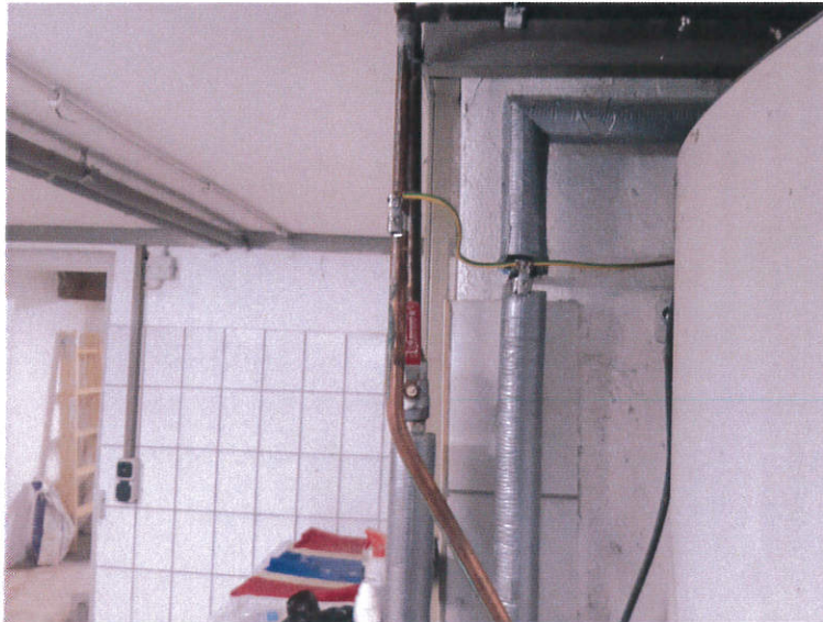
Bild 11: Potentialausgleich Kalt- und Warmwasserleitung
