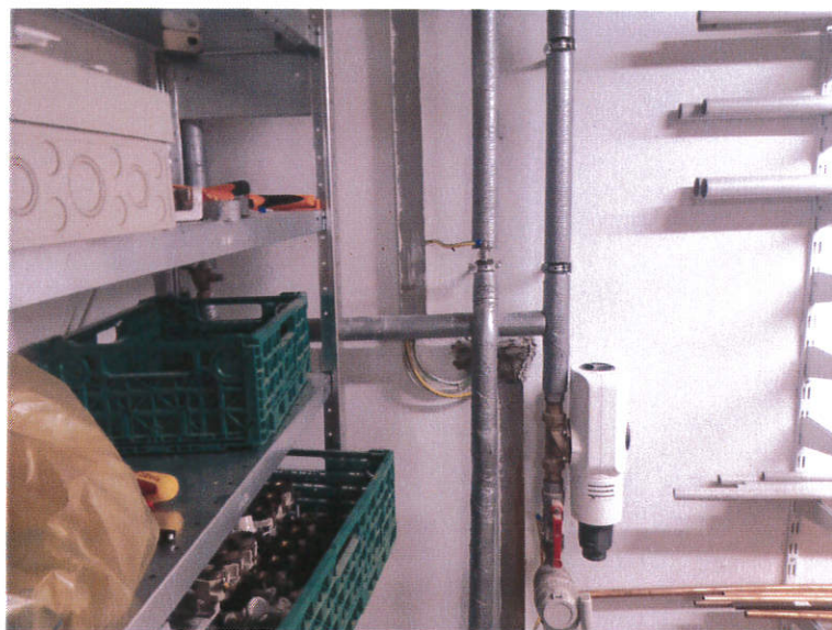
Bild 10: Potentialausgleich Kaltwasserleitung
